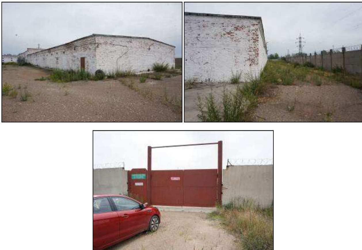
Фото.66-68. Нежилое здание свинофермы корпус №2, назначение: нежилое, 2-этажный, общая площадь 1 716,1 кв. м., инв. № 11711, лит. В с установленным комплектным свиноводческим оборудованием
