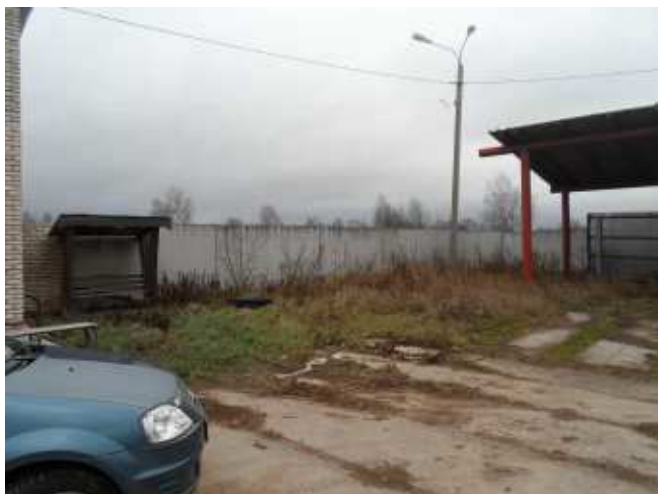
Фото 3. Ограждение с проходной ЛПЦ (Бор) (Вид 3)
