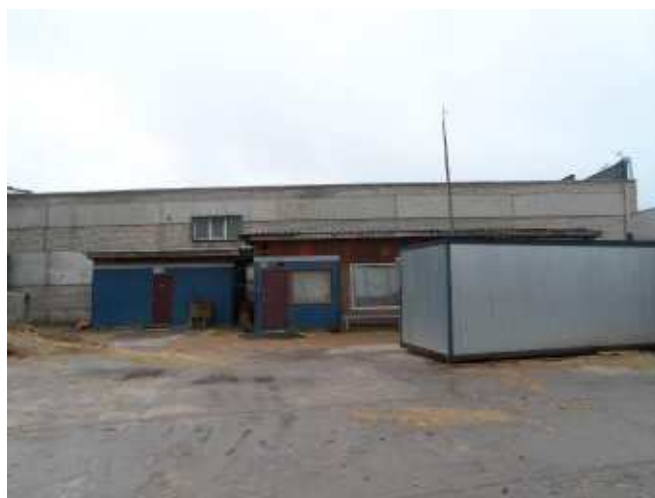
Фото 48. Здание цеха по переработке древесины (Вид 2)
