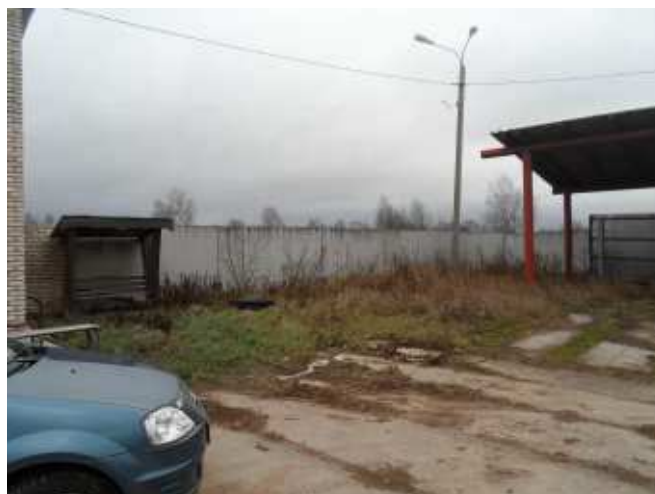
Фото 22. Ограждение производственной территории в пос. Бор (Вид 4)
