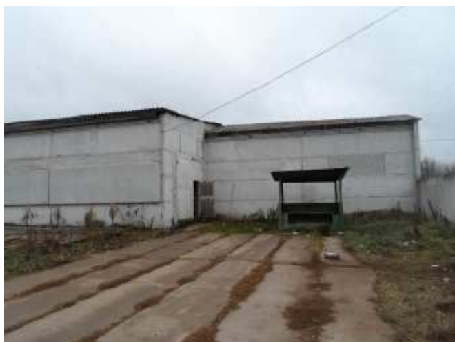
Фото 11. Административно-бытовой корпус ЛПК (Бор) (Вид 3)
