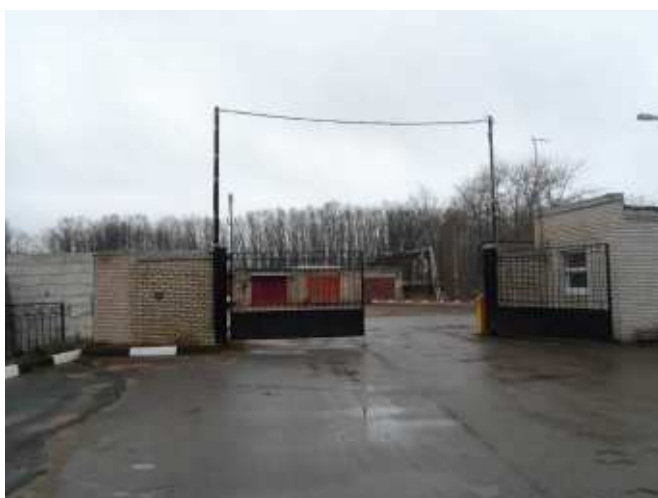
Фото 29. Ограждение с проходной (Вид 1)
