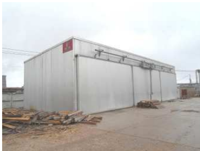
Фото 32. Сушильный комплекс из трех камер
