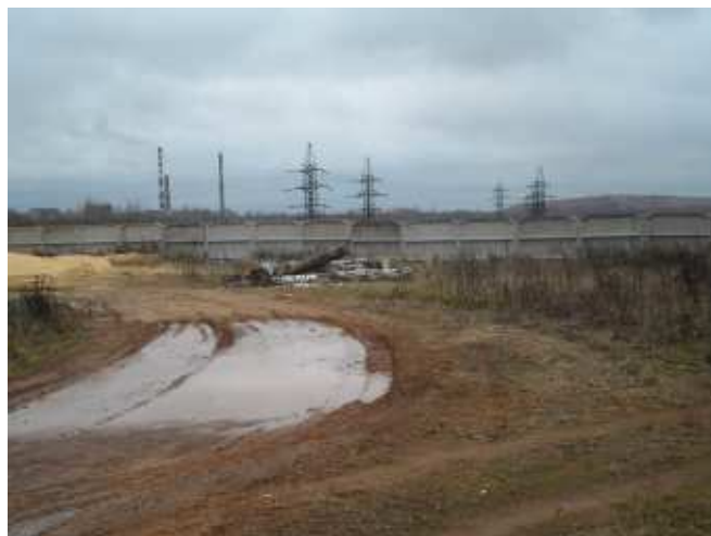
Фото 20. Ограждение производственной территории в пос. Бор (Вид 2)
