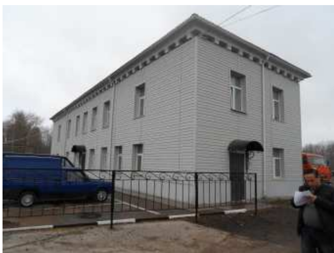
Фото 27. Административное здание (Вид 1)
