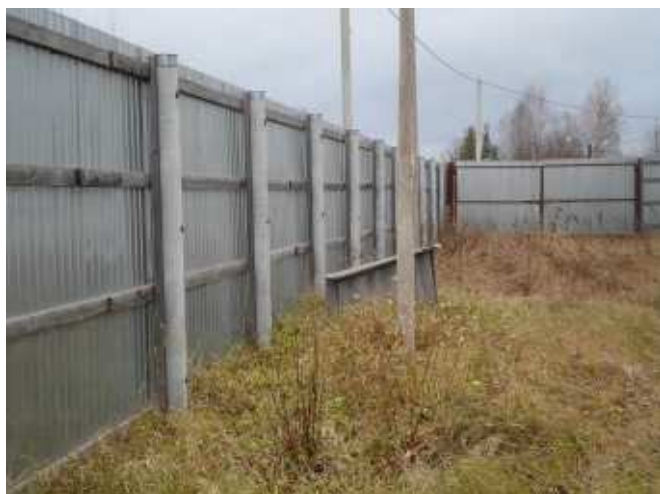
Фото 21. Ограждение производственной территории в пос. Бор (Вид 3)
