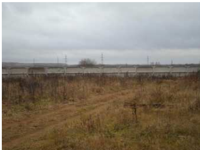
Фото 19. Ограждение производственной территории в пос. Бор (Вид 1)
