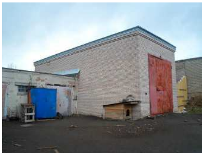
Фото 46. Гараж (пристройка к складу хранения оборудования)
