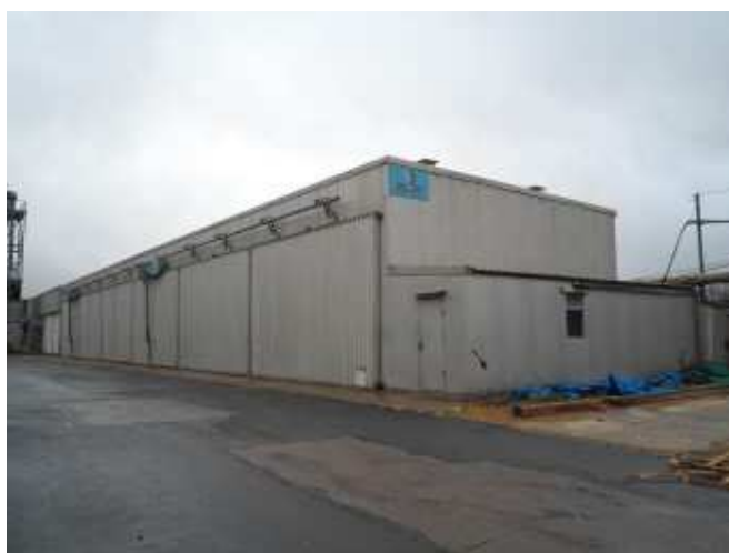
Фото 40. Сушильный комплекс из шести камер
