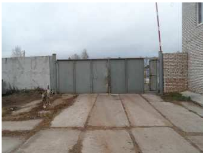
Фото 1. Ограждение с проходной ЛПЦ (Бор) (Вид 1)
