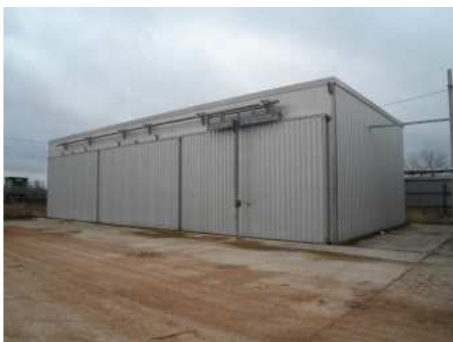
Фото 15. 3-х секционная сушильная камера (Бор) (Вид 2)
