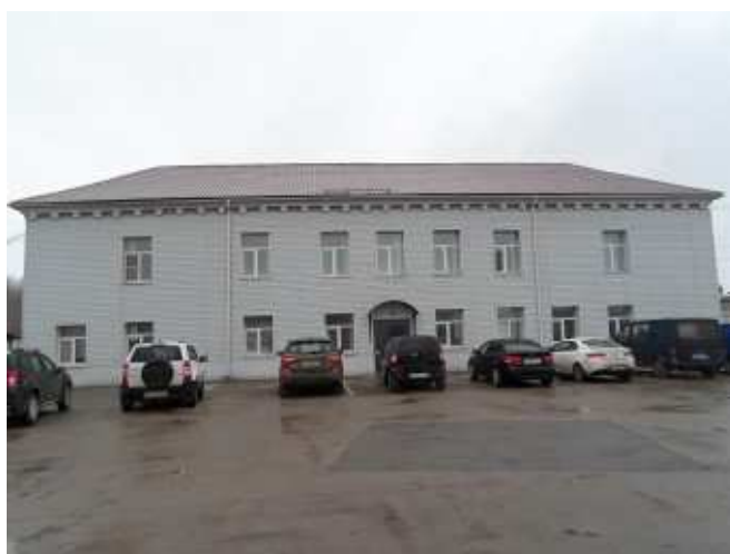
Фото 28. Административное здание (Вид 2)
