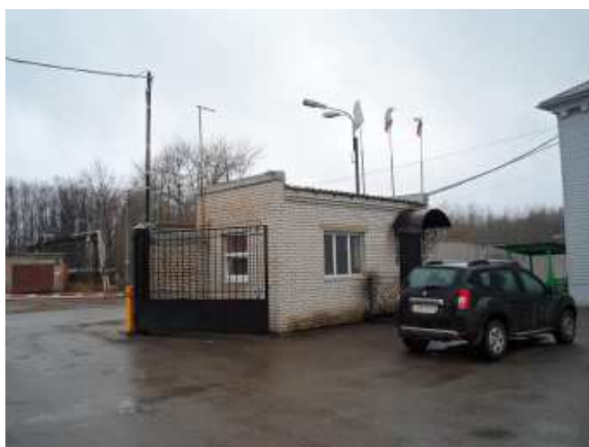
Фото 30. Ограждение с проходной (Вид 2)
