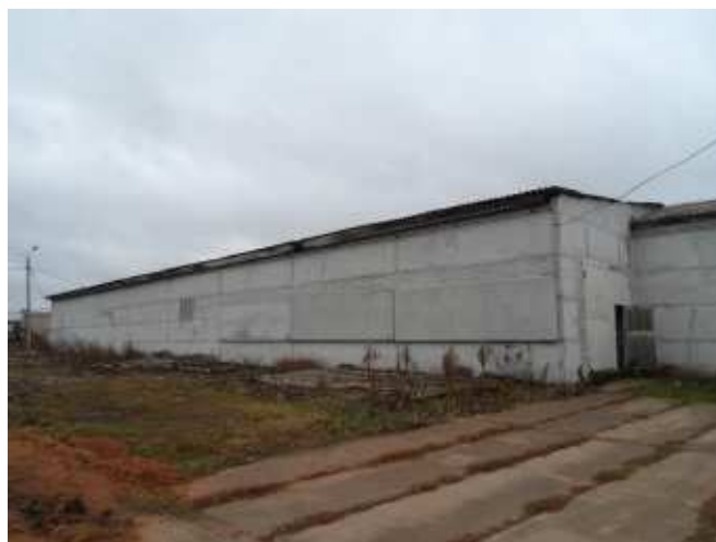
Фото 10. Административно-бытовой корпус ЛПК (Бор) (Вид 2)
