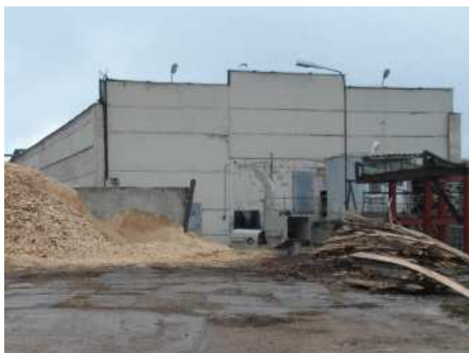
Фото 47. Здание цеха по переработке древесины (Вид 1)
