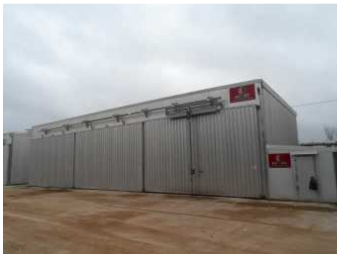
Фото 14. 3-х секционная сушильная камера (Бор) (Вид 1)
