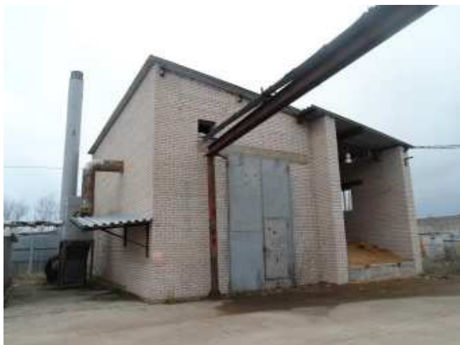
Фото 13. Котельная (Бор) (Вид 2)
