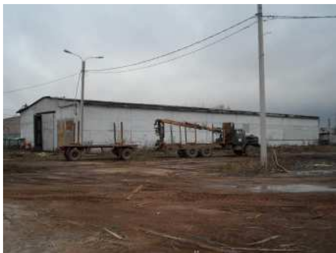
Фото 9. Административно-бытовой корпус ЛПК (Бор) (Вид 1)
