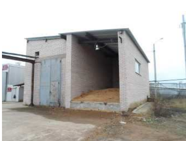
Фото 12. Котельная (Бор) (Вид 1)
