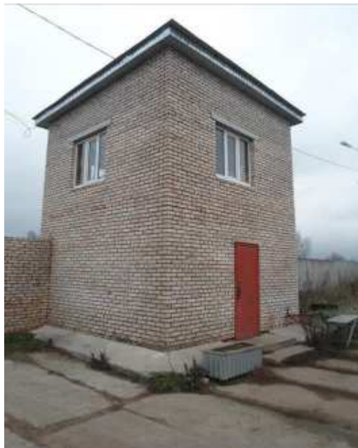
Фото 2. Ограждение с проходной ЛПЦ (Бор) (Вид 2)
